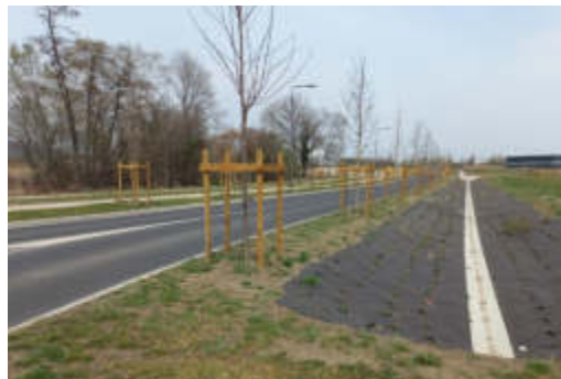
Voie Sud réalisée (2023)
