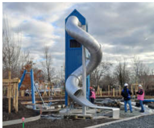
Chantier du BuPa (mars 2024)
