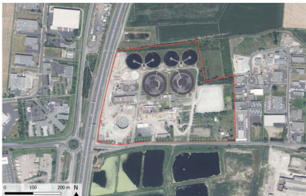
Localisation du site de la STEP
